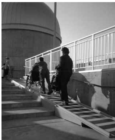
新設された手すりとスロープ
